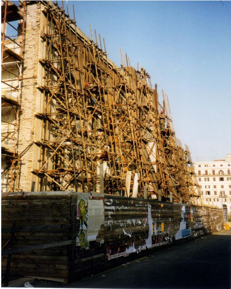
Foto 1 – Integrazione delle opere di rinforzo
