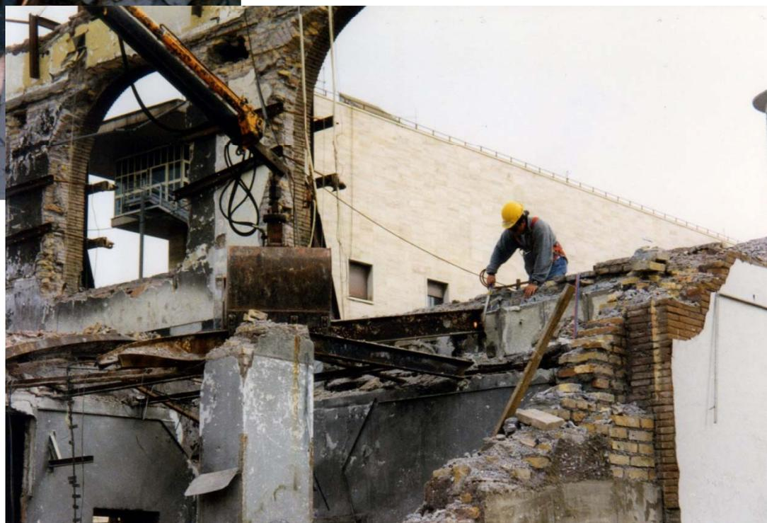
**Foto 9 – Rimozione del materiale di risulta**
