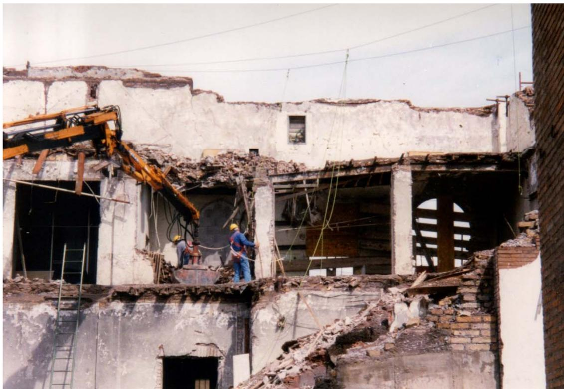
**Foto 6 – Fase di rimozione del materiale di risulta. E' ben visibile il sistema di funi a cui erano assicurati gli addetti a tale fase lavorativa**
