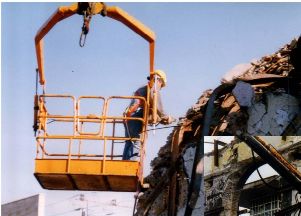
**Foto 8 – Particolare lavorazione con l'ausilio del cestello su autogrù**
